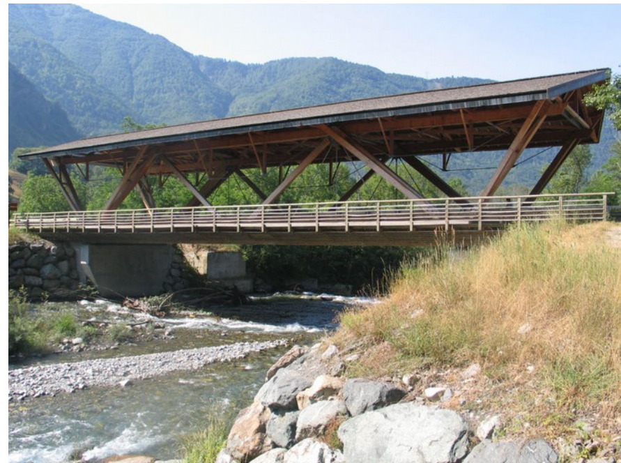
Pont des Fayette's (2000) – Pont à poutres latérales en treillis – Photo DTerEst
