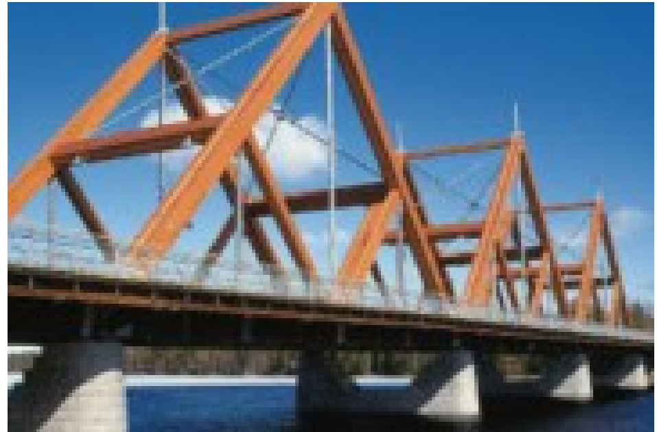
Pont de Vihantasalmi (1999) – Pont à fermes et bow-string – Photo DTerEst
