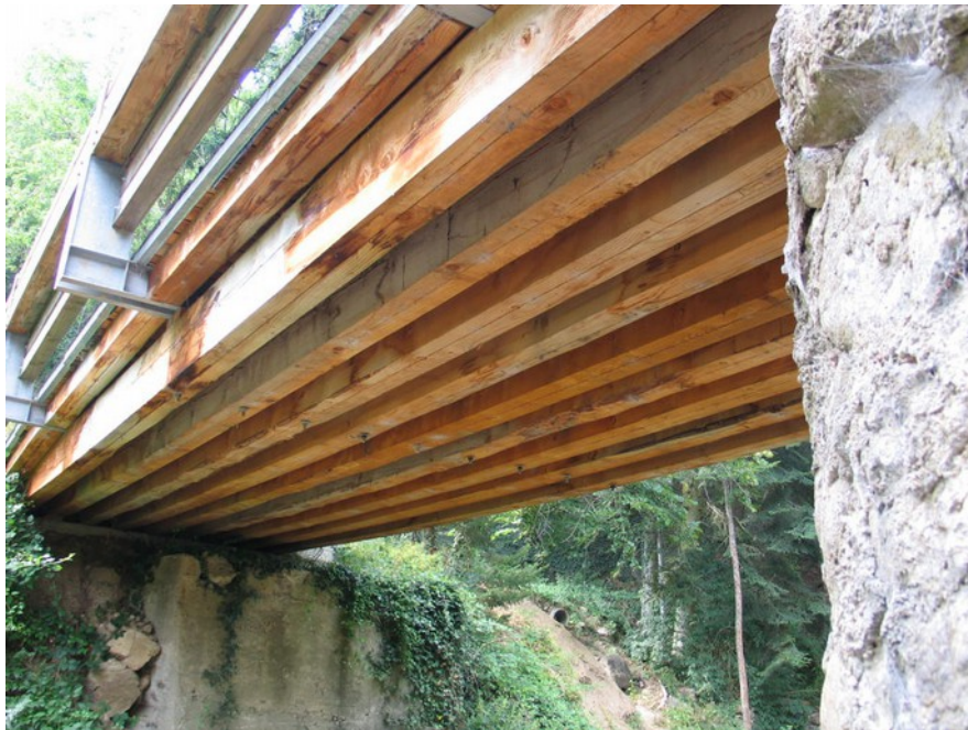
Pont de Vocance (2000) – Pont à poutres – Photo DTerEst
