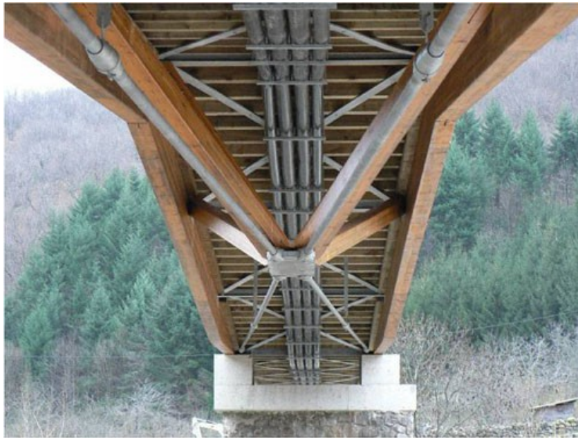
Pont du Bouix (2007) – Pont à poutres sous-tendues – Photo CNDB
