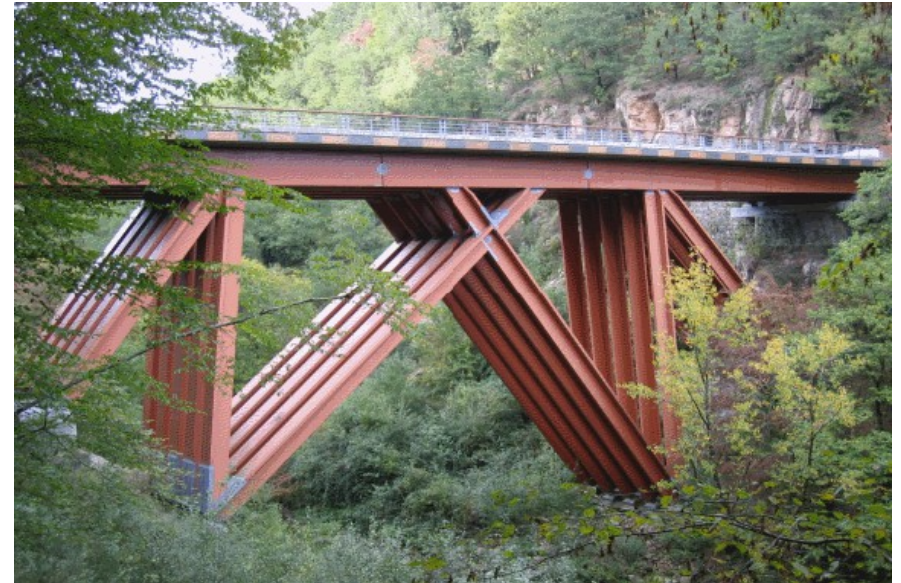
Pont de Merle (1999) – Pont à béquilles – Photo DTerEst
